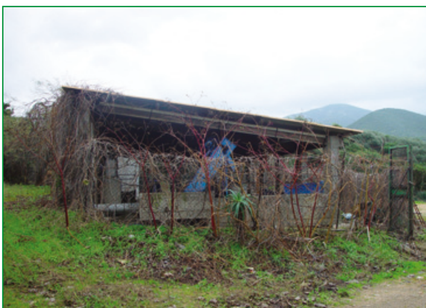
Vue de la STEP "boues activées" d'une capacité de 400 EH
