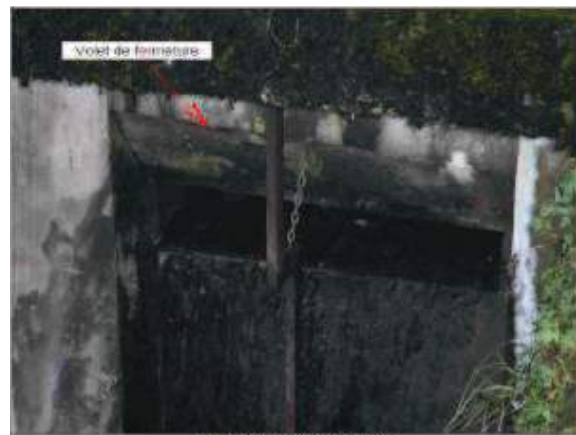
Exutoire en Loire du déversoir
