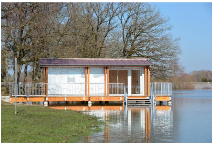
Photo du poste de surveillance (construit en 2016)
