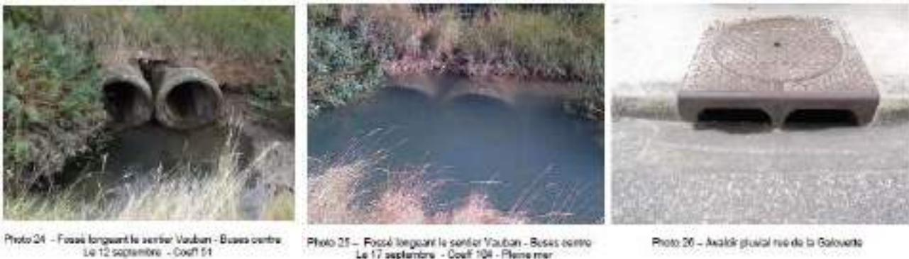
**Figure 42** : Réseau pluvial du sud de Saint-Vaast-la-Hougue influencée par la remontée des eaux marines – clichés tirés du rapport d'étude de la DT50 ARS BN (ARS, 2012)
