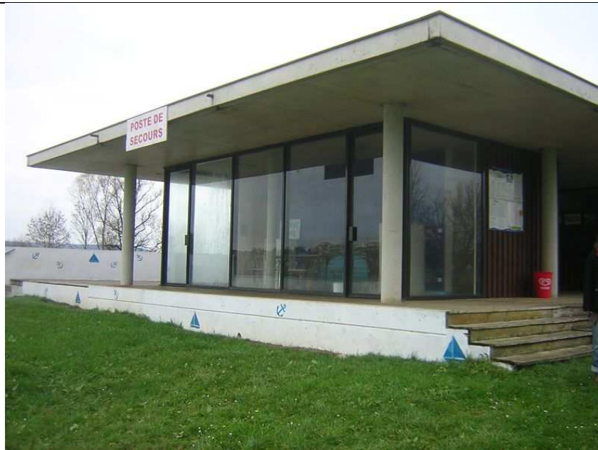
Figure 16: poste de secours de la plage
