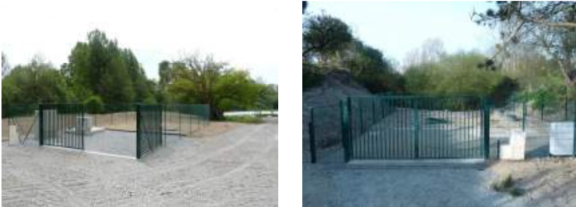
Figure 83a et b : Construction du poste de la Moinerie et de sa bache de sécurisation sur la commune de SAINT-PLANCHERS – Réhabilitation du poste de Prétôt sur la commune de GRANVILLE – Cliché SMAAG 2010
