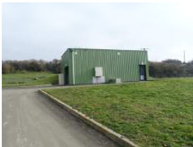
Figure 81 : Construction du poste de Scissy et de sa bache de sécurisation à ST-PAIR/MER – Cliché SMAAG
