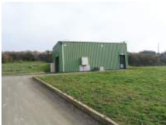
Figure 87: Construction du poste de Scissy et de sa bache de sécurisation à ST-PAIR/MER – Cliché SMAAG
