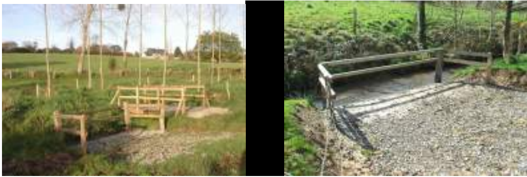
Figure 84 : clichés de travaux de restauration des cours d'eaux.
