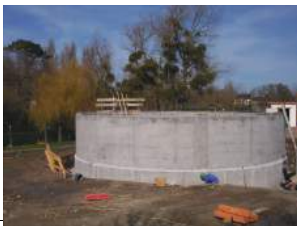
Figure 85 a et b : Construction du poste de Mallouet et de sa bache de sécurisation à GRANVILLE – Construction de la bache de sécurisation du poste de refoulement de
