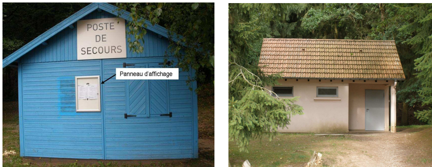
Figure 17 : poste de secours et sanitaires de la plage
