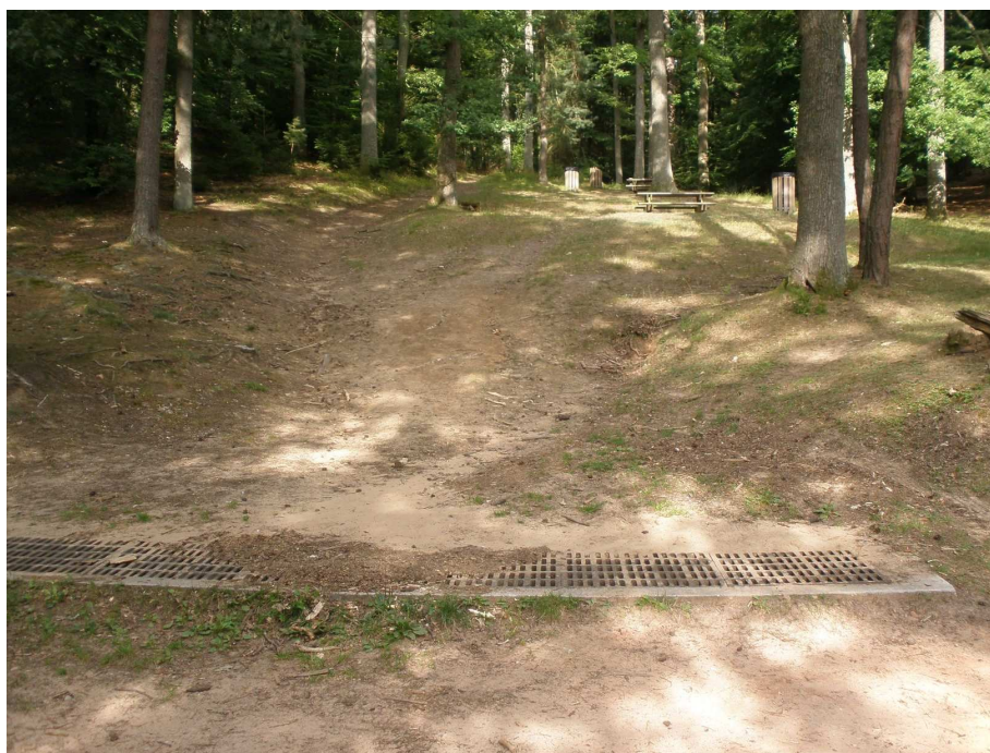
Figure 31: grille de collecte des eaux de ruissellement
