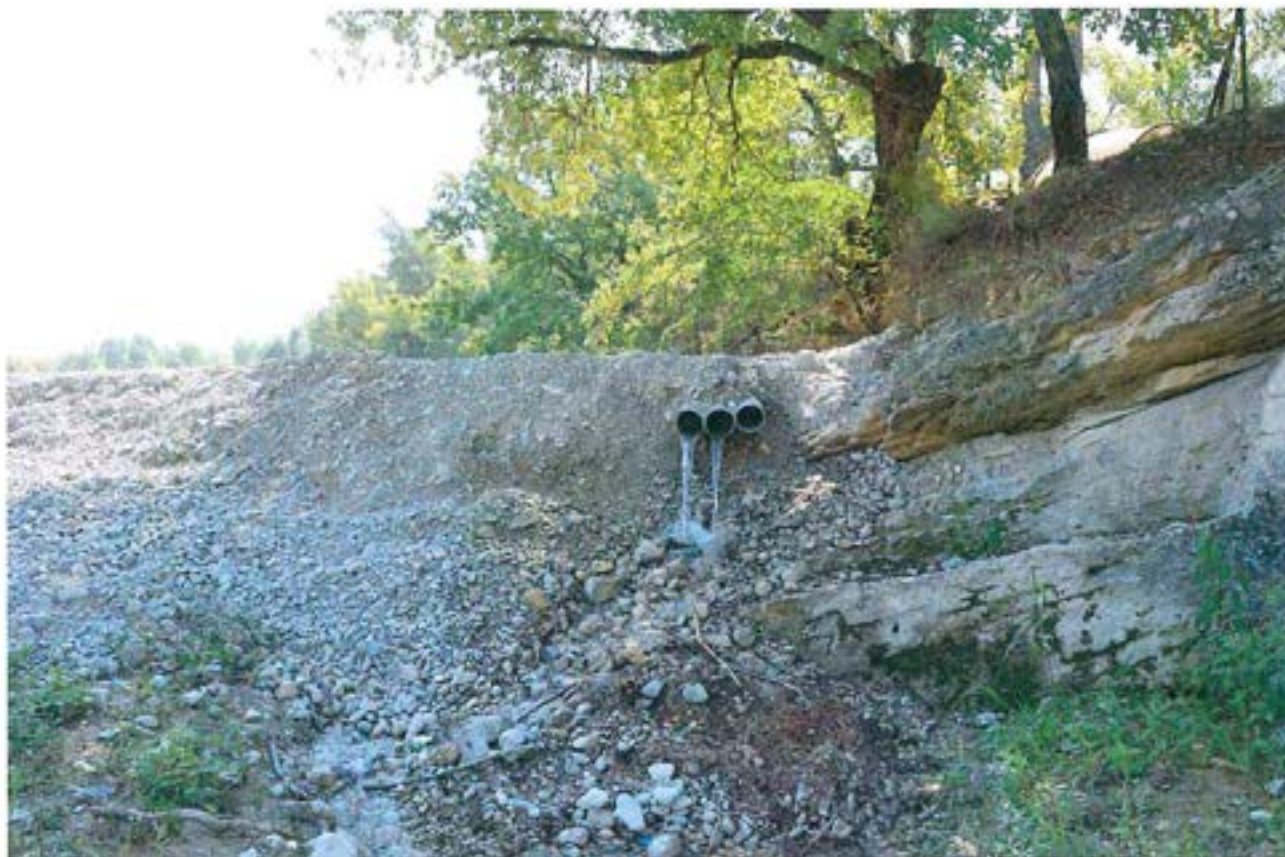
Photo 4 : ouvrage de sortie
