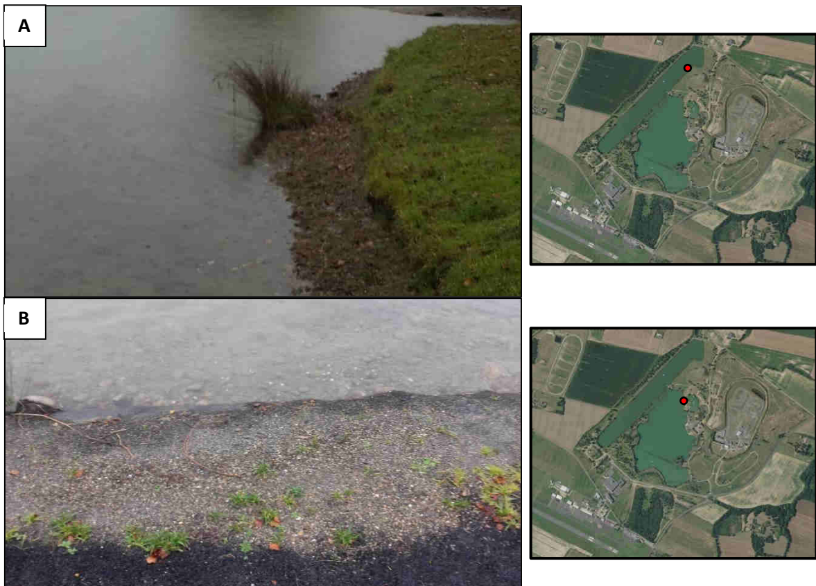
Photo 4: Etat général des berges (A) et protection des berges en zone de baignade (B) du lac des Bonnets
