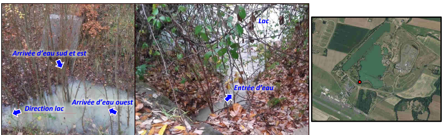
Photo 2: Arrivée d'eau pluviale dans le lac des Bonnets, via un fossé
