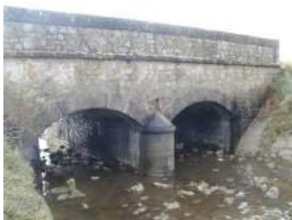
Figure 22 : Vue sur l'exutoire de l'Ouve
